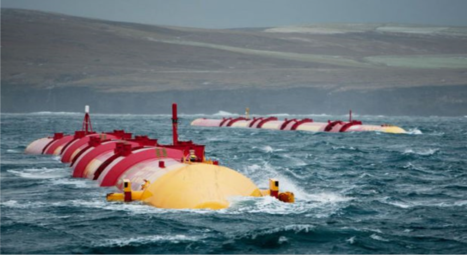
Zonguldak sahilinde bulunan Pilot Dalga Enerji uygulaması
